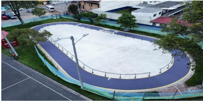
Mantenimiento 15-040 La Fragua Pista de Patinaje
