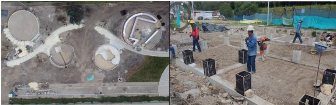
Fuente: Subdirección Técnica de Construcciones
