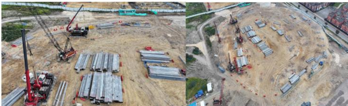
Fuente: Subdirección Técnica de Construcciones
