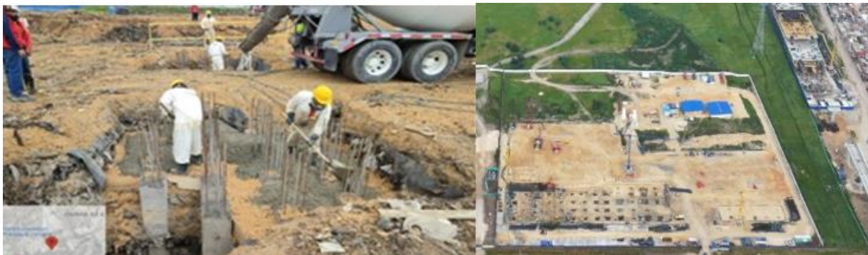
Fuente: Subdirección Técnica de Construcciones
