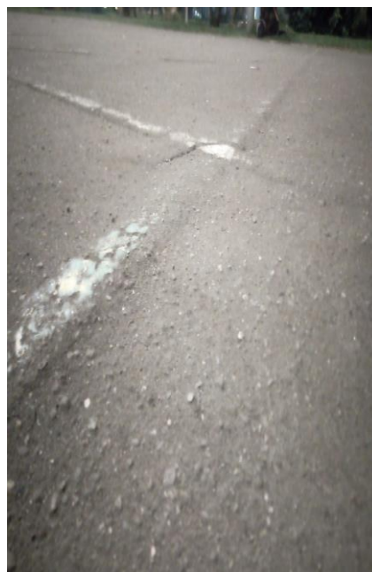
(Capa asfáltica del polideportivo en alto estado de desgaste)
